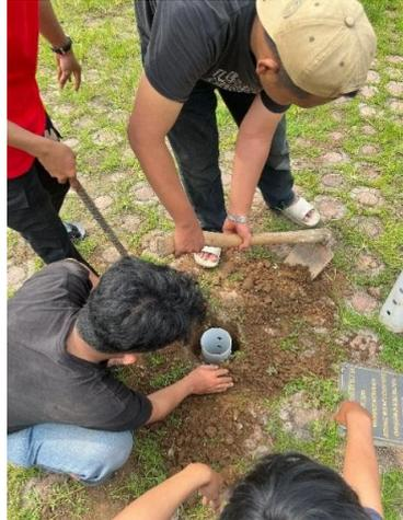
**Gambar 4.** Pemasangan Sumur Biopori
