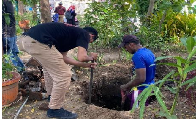
Gambar 1. Proses penggalian lubang untuk teba modern di Jalan Amkop Makassar
