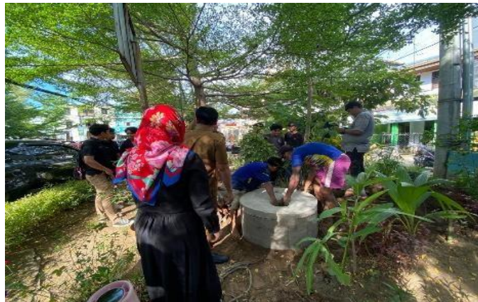
Gambar 2. Proses pembuatan teba (pemasangan gorong-gorong dan penutup)
