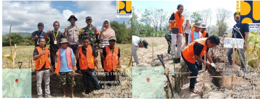
Gambar 2. Pekerjaan Saluran Irigasi
