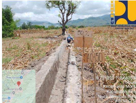
Gambar 3. Pekerjaan Saluran Irigasi Batu Kali
