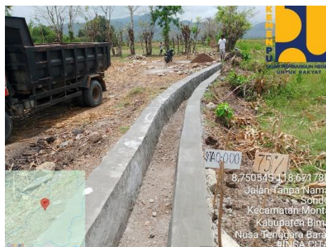
Gambar 4. Pekerjaan Saluran Irigasi Beton
