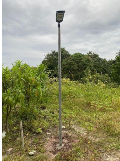
Gambar 2. Lampu PJU telah Terpasang
