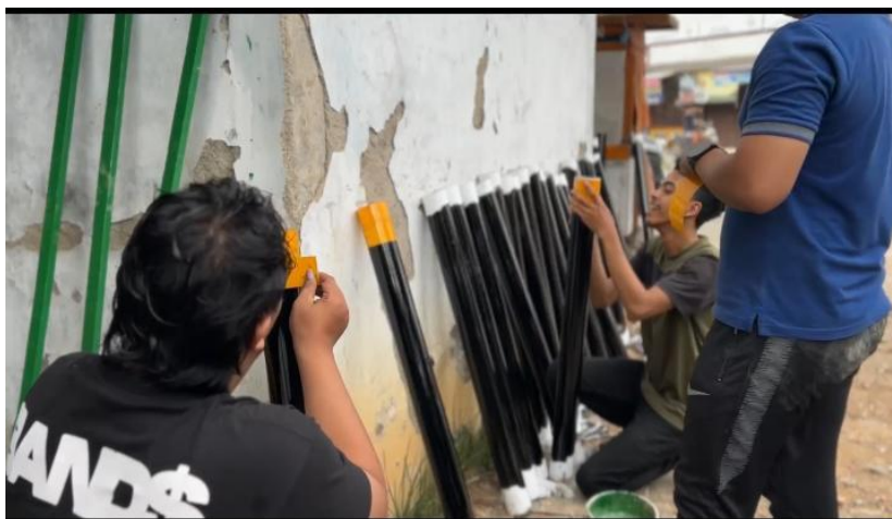
Gambar 3. Proses Pembuatan Delineator Berbahan Pipa PVC
