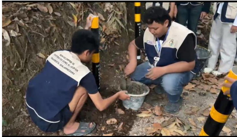
Gambar 4. Proses Pemasangan Delineator pada Titik Prioritas
