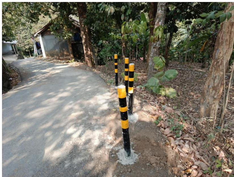
Gambar 5. Kondisi Ruas Jalan Setelah Pemasangan Delineator
