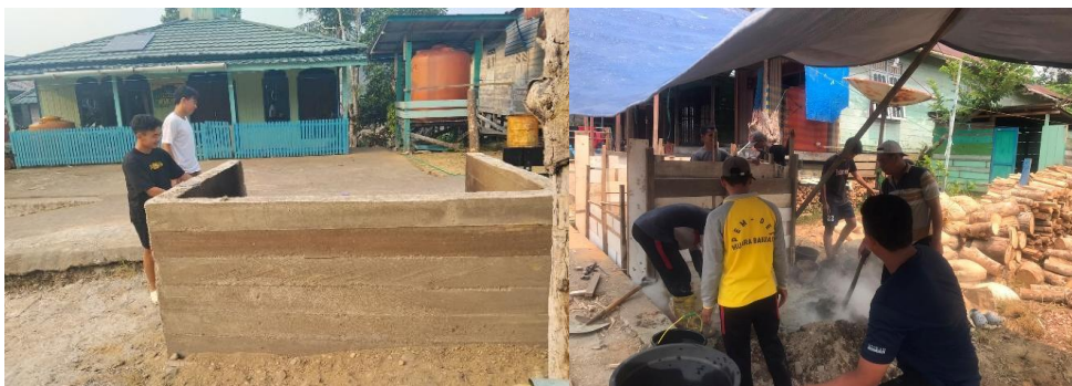
Gambar 3. Proses Pembuatan Tempat Pembuangan Sampah (TPS)
